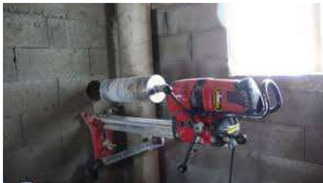
Traversées de parois au moyen de carotteuses
