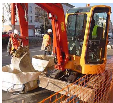
Mini-pelle sur chantier
