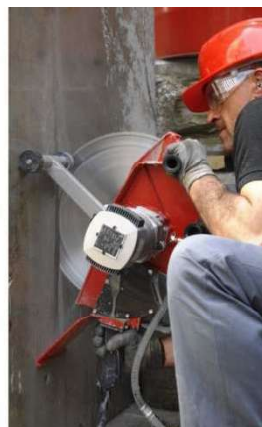
Installation puis utilisation d'une carotteuse sur bâti
