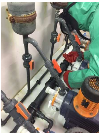
Maintenance sur pompes doseuses ou circuit de dosage
