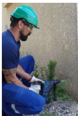
Trou avec un perforateur
