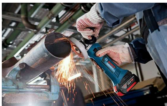
Chanfreinage d'une tuyauterie en atelier
