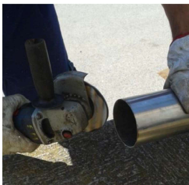
Meulage d'un tuyau
