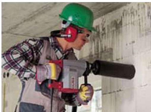
Traversées de parois au moyen de carotteuses
