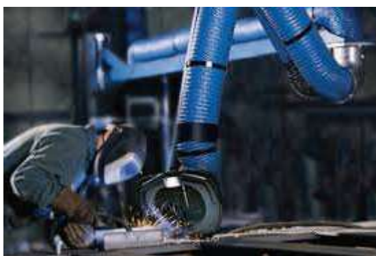
Soudure en atelier avec aspiration des fumées
