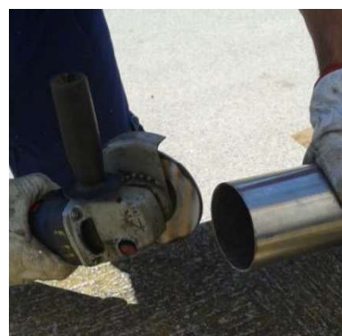
Meulage d'un tuyau
