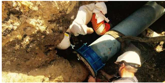
Raccordement d'une canalisation dans une tranchée par deux agents de maintenance à genoux (intervention en espace exigü)
