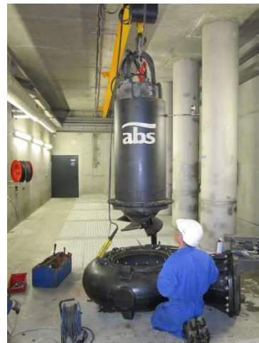
Réhabilitation d'une pompe sur chantier en position à genoux.
